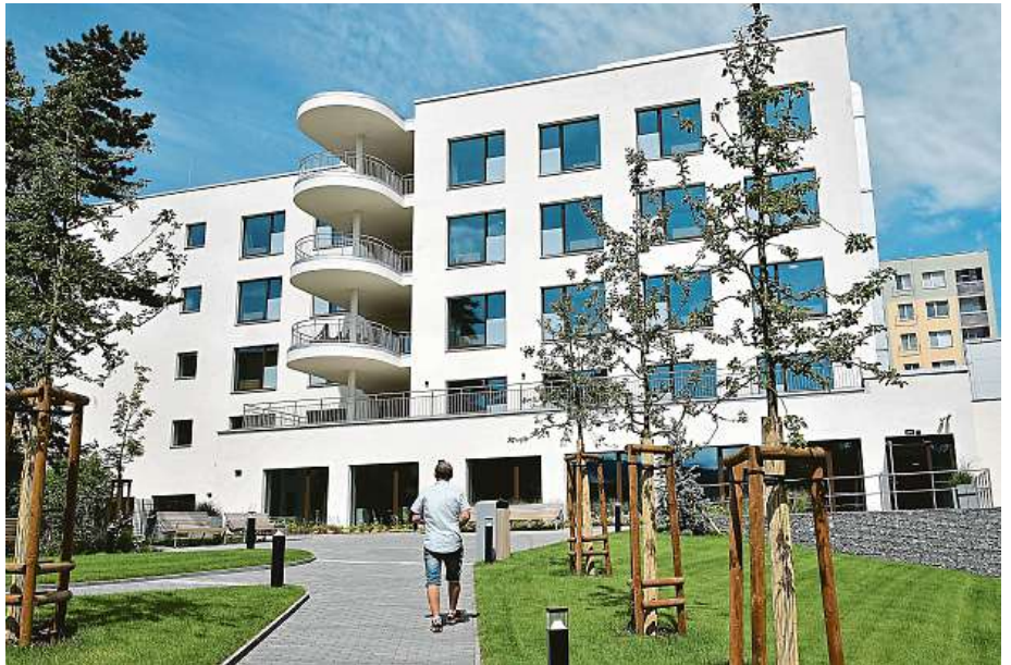
DOMOV POD BÍLOU HOROU NOVÝ DOMOV V KOPŘIVNICI MÁ KAPACITU 84 LŮŽEK, Z TOHO 32 PATŘÍ DOMOVU PRO SENIORY, ZBYTEK DOMOVU SE ZVLÁŠTNÍM REŽIMEM.
